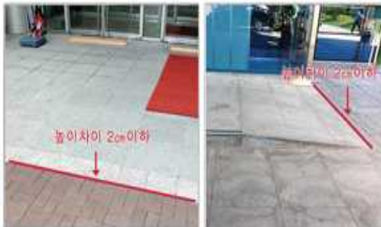
주출입구와 연결접근로의 높이차이가 2cm이하인 사례 사진
